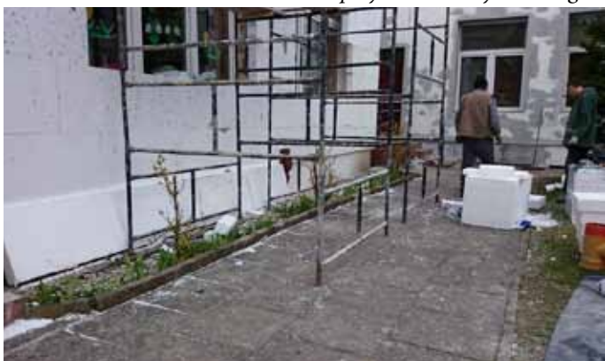
Ocieplanie budynku Przedszkola nr 3
