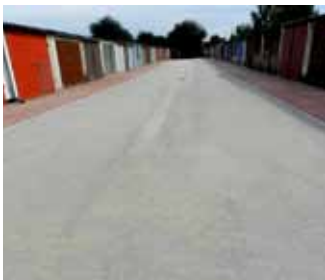
Dojazd do garaży po remoncie
