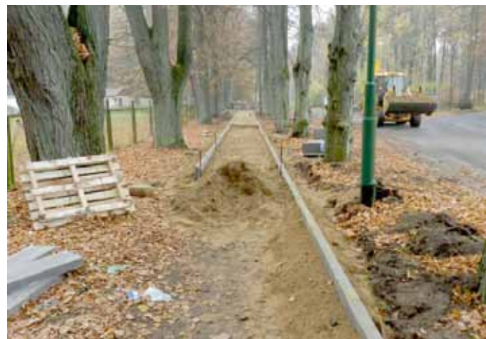
w czasie remontu
