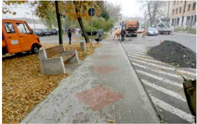
w trakcie remontu
